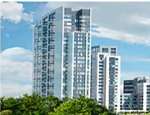
Een bedrijfspand met een statische en dynamische verliesverhouding van 50/50. Het dynamische drukverlies is gebaseerd op 500 meter waterleiding met een specifiek drukverlies van 450 Pa/m plus verliezen in componenten.
